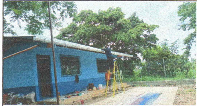
Foto 7: Sustitución de canal de metal
