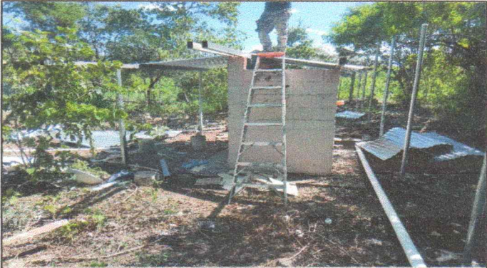
Foto1: Sustitución de lámina, por lamina troquelada
