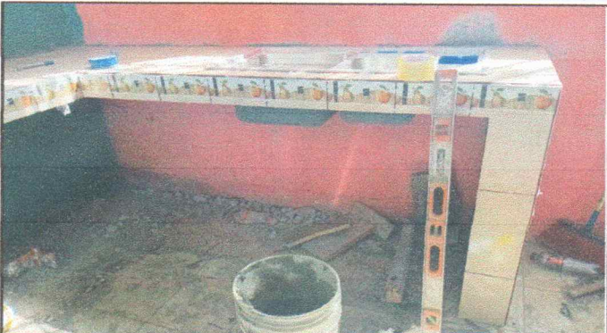
Foto 14: Sustitución de azulejos en muebles de cocina
