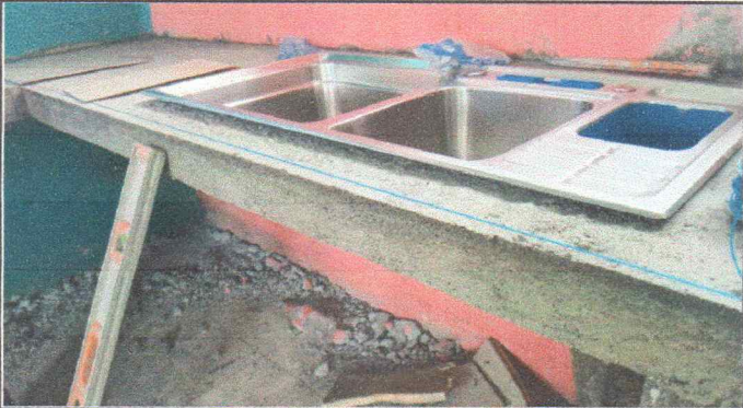
Foto 13: Sustitución de lavatrastos con base de concreto
