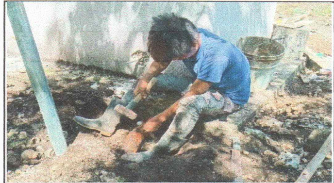
Foto 9: Repación en tubería de PVC línea principal
