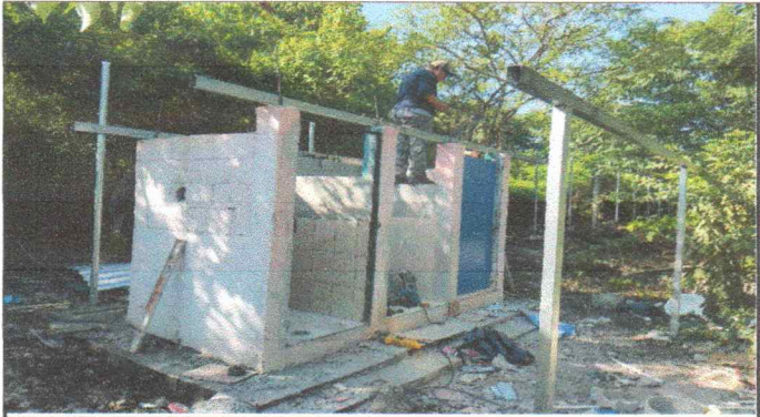
Foto 2: Sustitución de soporte de madera por metal
