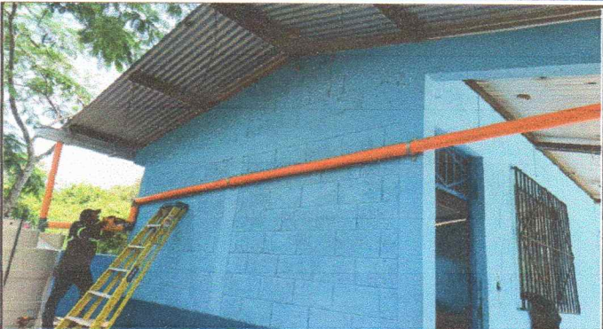
Foto 8: Sustitución de bajada de agua pluvial
