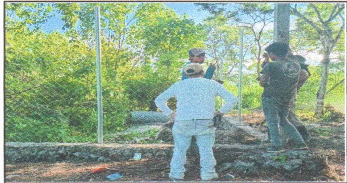
Foto 11: Reparación de muro perimetral
