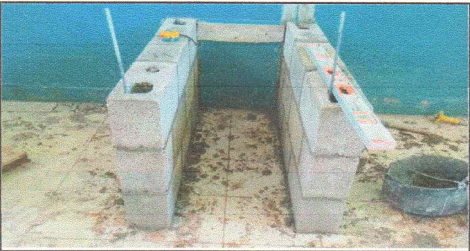
Foto 12: Sustitución de estufa rural completa
