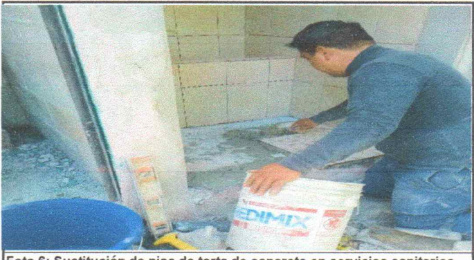
Foto 6: Sustitución de piso de torta de concreto en servicios sanitarios
