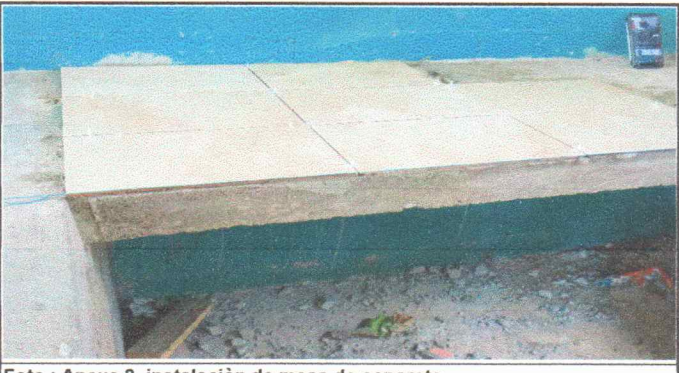
Foto : Anexo 3. instalación de mesa de concreto
