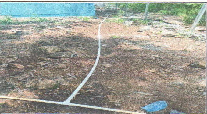
Foto 10: Repación en tubería de PVC línea principal
