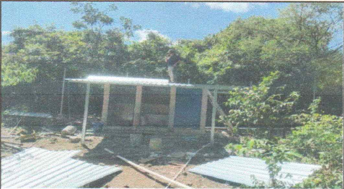
Foto. Anexo 1. Instalación de capotes en techo de lamina
