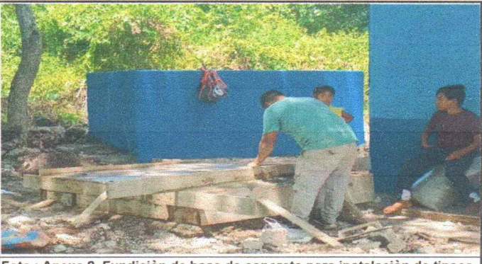
Foto : Anexo 2. Fundición de base de concreto para instalación de tinaco
