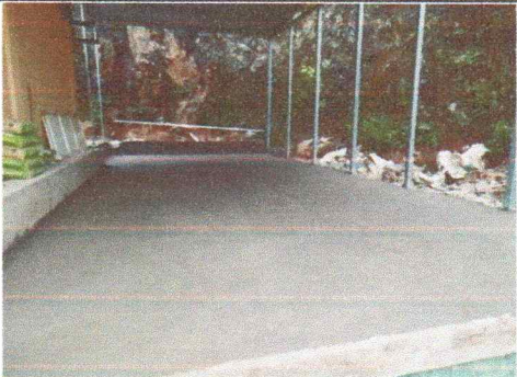
Foto 3: La fotografía muestra el área intervenida tras la sustitución de la torta de cemento. Se aprecia una superficie renovada, uniforme y bien compactada, que mejora la seguridad, estabilidad y funcionalidad del espacio.
