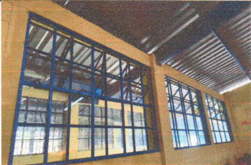
Foto 6: La imagen muestra los balcones de metal ya mejorados e instalados en las ventanas, ofreciendo mayor protección y una apariencia renovada.
