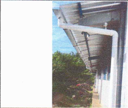
Foto1: El nuevo canal se encuentra firmemente instalado, limpio y sin daños, permitiendo una adecuada evacuación de agua y protegiendo la estructura del establecimiento de filtraciones y deterioro.
