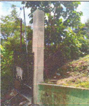
Foto 2: La fotografía muestra el resultado final de la sustitución del repello en las columnas principales. Se aprecia una superficie renovada, correctamente nivelada y lista para recibir pintura, mejorando la apariencia y protección de la estructura.
