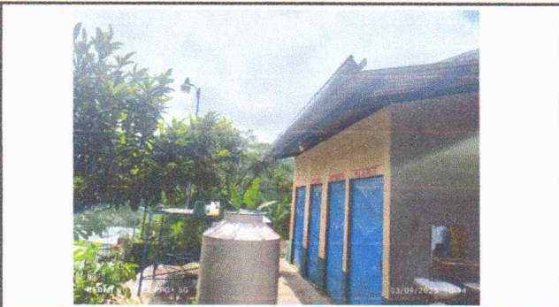
Foto 4: Sustitución de canal de metal.
