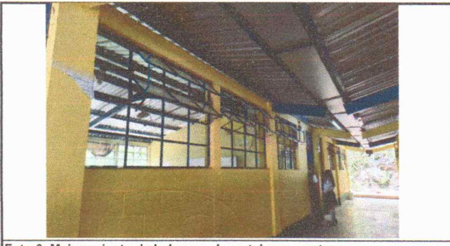
Foto 6: Mejoramiento de balcones de metal para ventanas.
