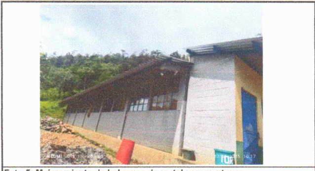
Foto 5: Mejoramiento de balcones de metal para ventanas.
