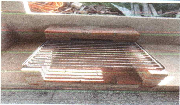
Foto 5: Sustitución de estufa Rural
