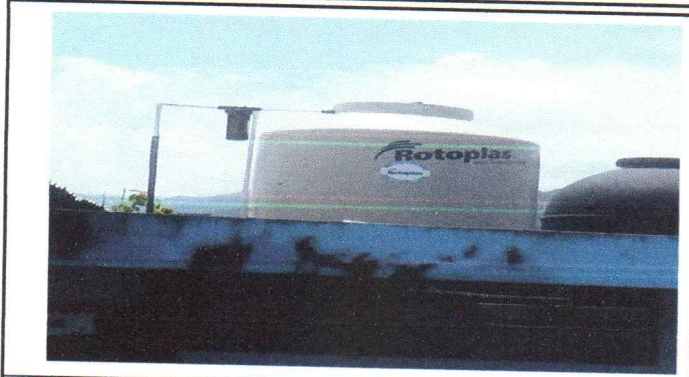
Foto 2: Sustitucion de depósito de agua
