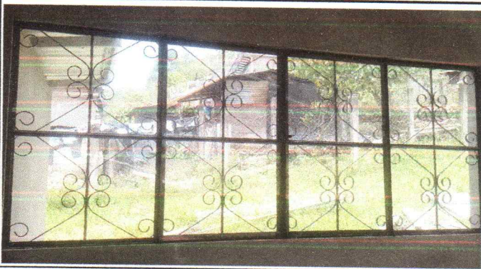
Foto 3: Sustitución de ventana Metálica
