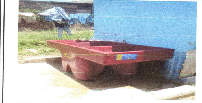
Foto1: Sustitucion de Pila de concreto
