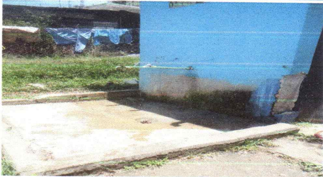
Foto1: Sustitucion de Pila de concreto
