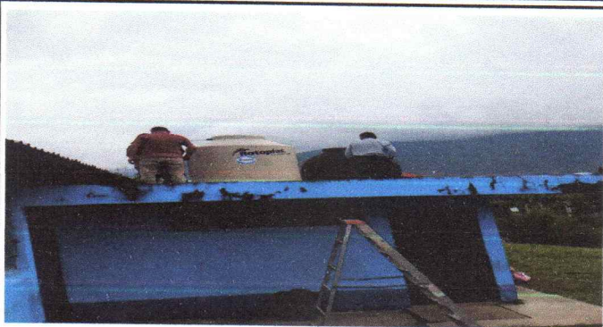
Foto 2: Sustitucion de depósito de agua
