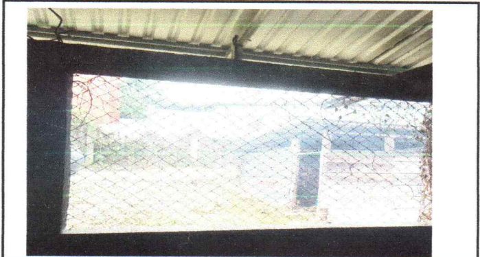
Foto 3: Sustitución de ventana Metálica
