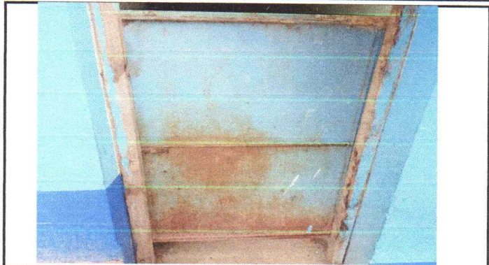
Foto1: Sustitucion de Puerta de Metal
