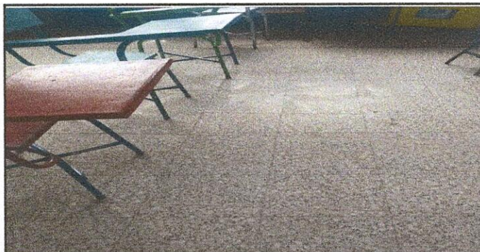
Foto 5: Sustitución de piso de torta en aulas, y dirección
