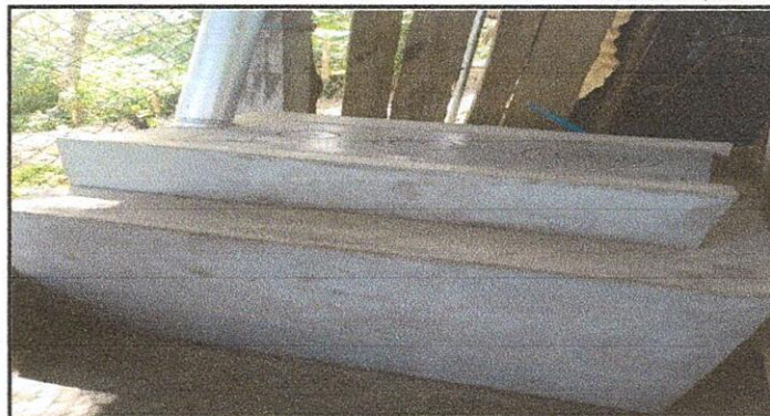
Foto 14: Sustrución de estufa rural por placha de metal
