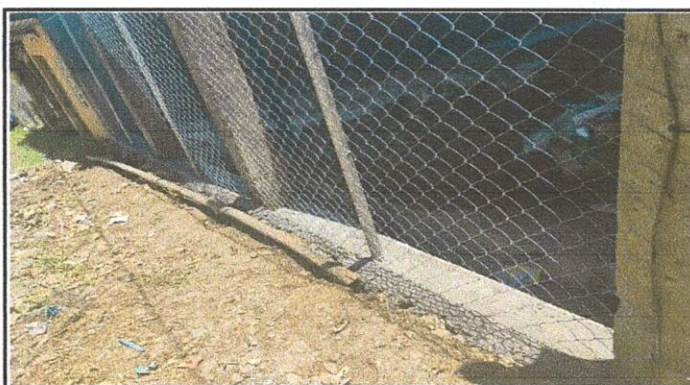
Foto 10: Sustitución de malla por malla
