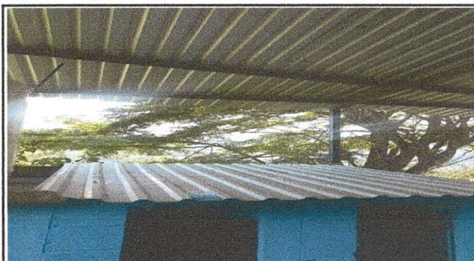
Foto 4: Sustitución de soporte de madera por tubo galvanizado
