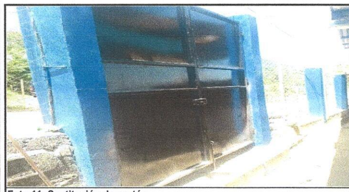
Foto 11: Sustitución de portón
