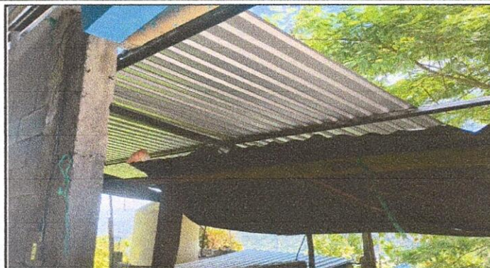
Foto 2: Cambio de techo de lámina por lámina troquelada calibre 26
