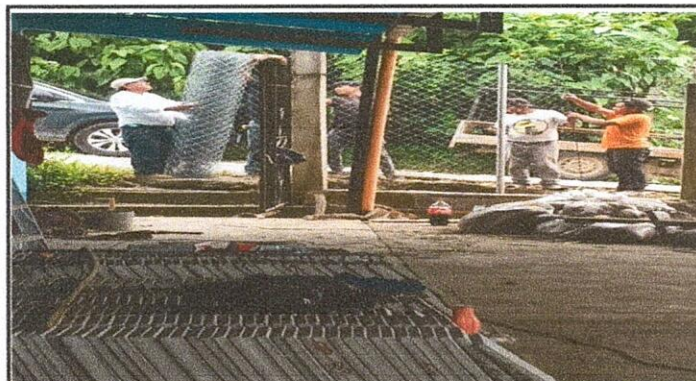
Foto 9: Sustitución de malla por malla
