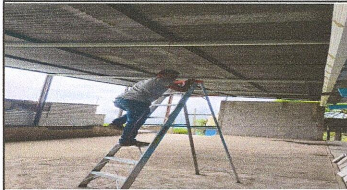
Foto 7: Reparación del Sistema Eléctrico
