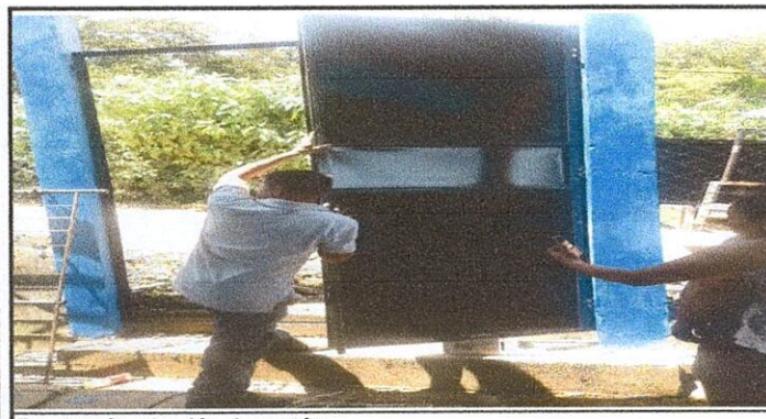
Foto 11: Sustitución de portón
