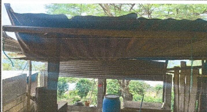
Foto1: Cambio de techo de lámina por lamina troquelada calibre 26
