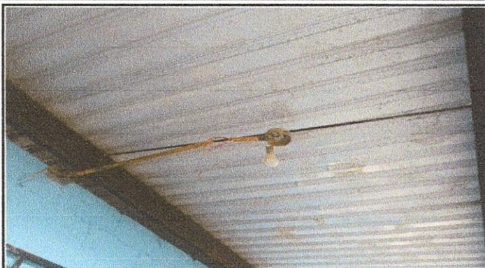
Foto 7: Reparación del Sistema Eléctrico
