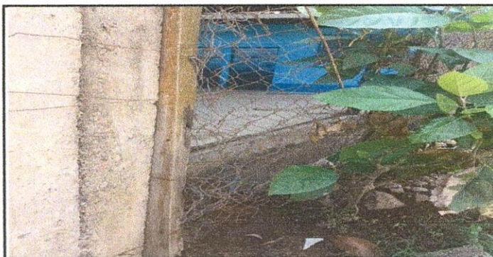
Foto 9: Sustitución de malla por malla
