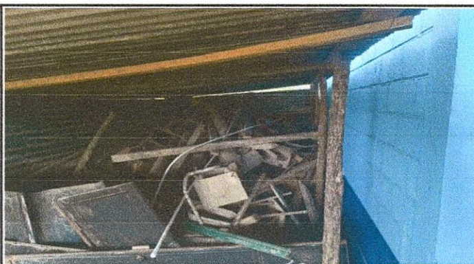
Foto 3: Sustitución de soporte de madera por tubo galvanizado
