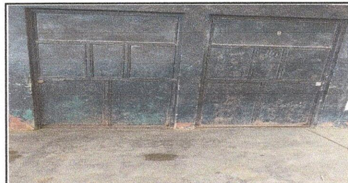
Foto 12: Reparación de puertas.
