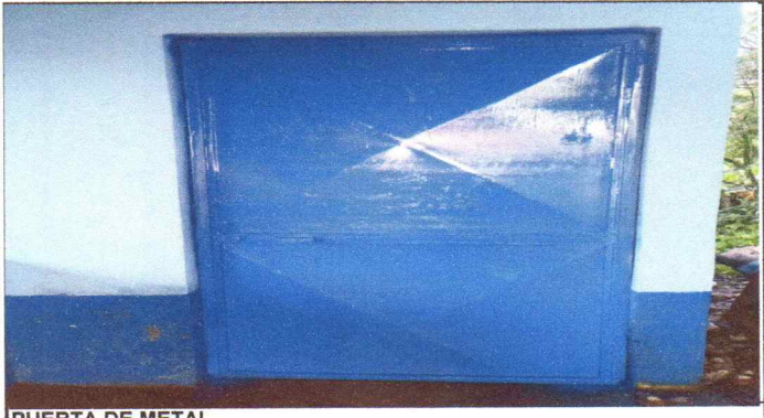
PUERTA DE METAL
