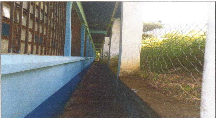
REPARACIÓN Y CERNIDO DE PAREDES
