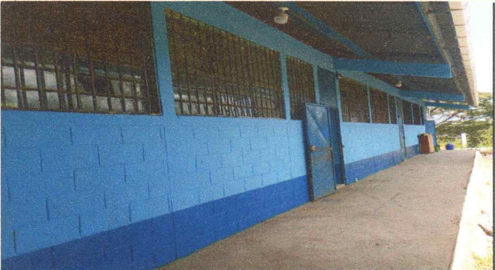
PINTURA EN MUROS EXTERIORES E INTERIORES
