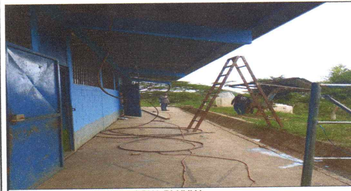
CANALES Y BAJADAS DE AGUA PLUVIAL
