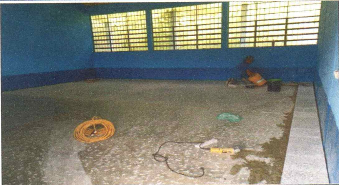
SUSTITUCIÓN DE PISO DE TORTA POR PISO DE GRANITO
