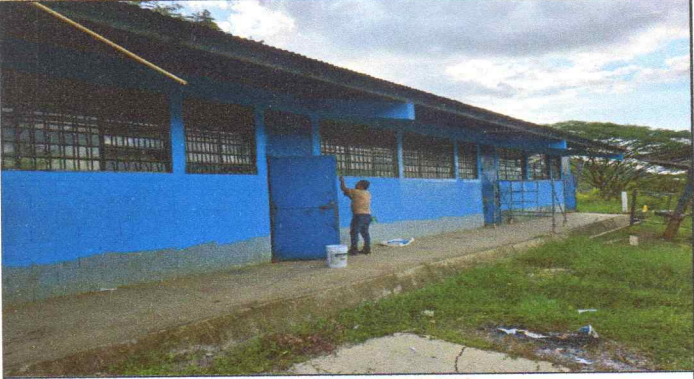
PINTURA EN MUROS EXTERIORES E INTERIORES
