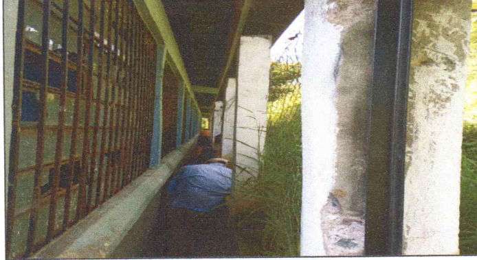
REPARACIÓN Y CERNIDO DE PAREDES
