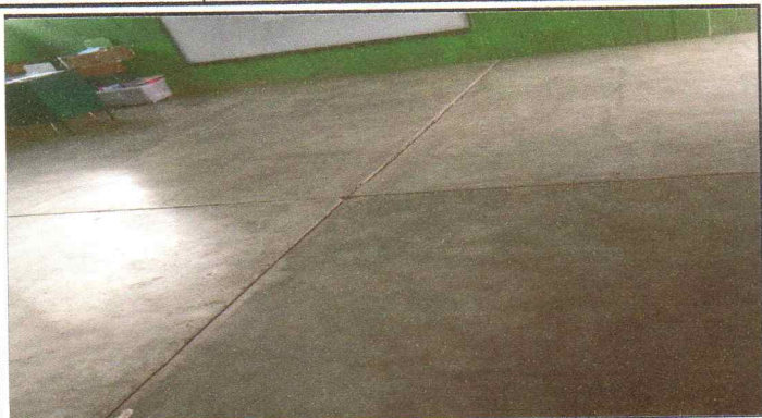
SUSTITUCIÓN DE PISO DE TORTA A PISO DE GRANITO
