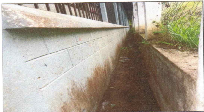
REPARACIÓN Y CERNIDO DE PAREDES
