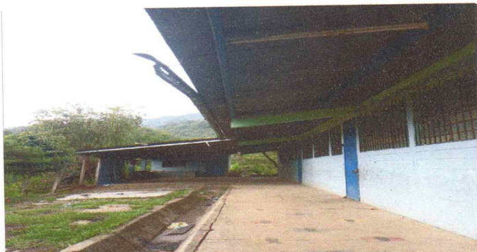
CANALES Y BAJADAS DE AGUA PLUVIAL
