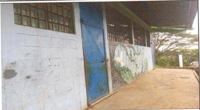
PINTURA EN MUROS EXTERIORES E INTERIORES
