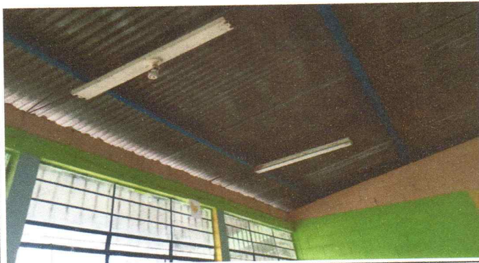
REPARACIÓN DE SISTEMA ELECTRICO
