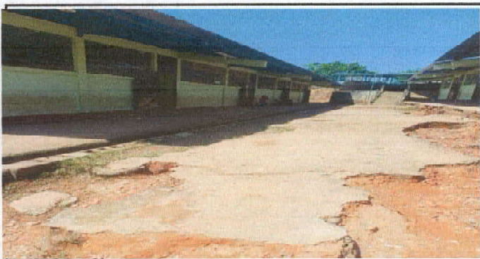
Foto 3: reparación de piso de torta de concreto del corredor y patio de las aulas
