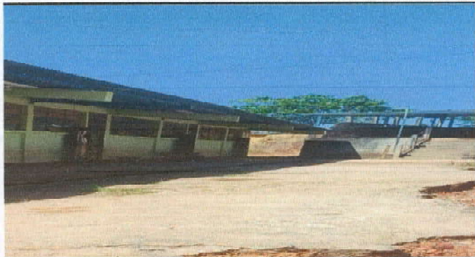
Foto 4: reparación de piso de torta de concreto del corredor y patio de las aulas
