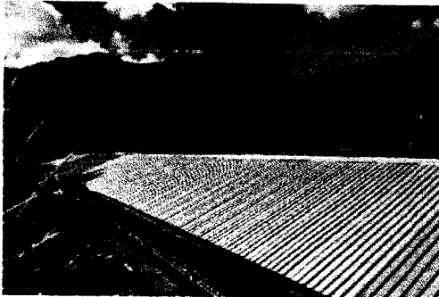
Foto 2: Techo de aulas, finalizado
