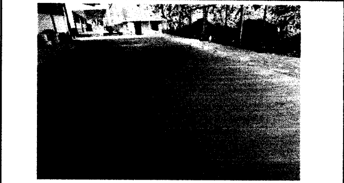
Foto1: Piso de concreto de patio, finalizado
