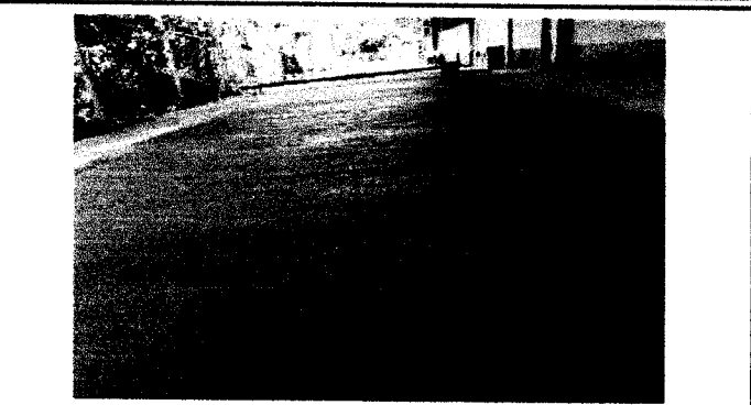
Foto 2: Piso de concreto de patio, finalizado (vista contraria)
