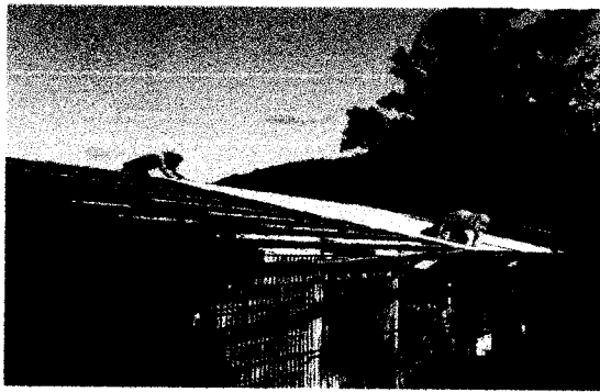
Foto1: Colocación de lámina troquelada (parte trancera del aula)
