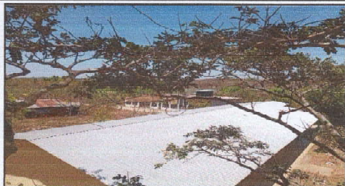
Foto1: Reparación y agregado de láminas por filtración de agua y pintado
