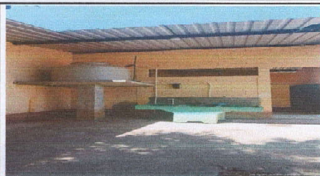
Foto 7. Sustitución de los depósitos de agua potable, una pila (depósito de agua de concreto) y un tinaco de 1000 ml de agua
