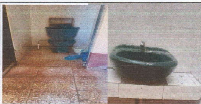
Foto 5: SUSTITUCION DE INODORO Y LAVAMANOS
