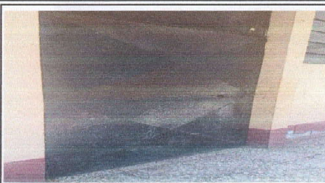
Foto 2: Mantenimiento a estructura; aplicación de pintura en 4 puertas.
