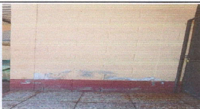
Foto 9. Pintado de paredes de las cuatro aulas, sanitarios, Dirección y centro de computación interior y exterior
