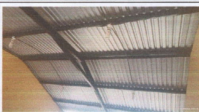
Foto 8. sustitución de 21 bombillas electricas
