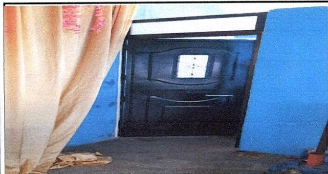
Foto 5: vista de puertas ya instaladas.
