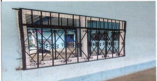
Foto 4: Ventanas en PVC. Y sus balcones
