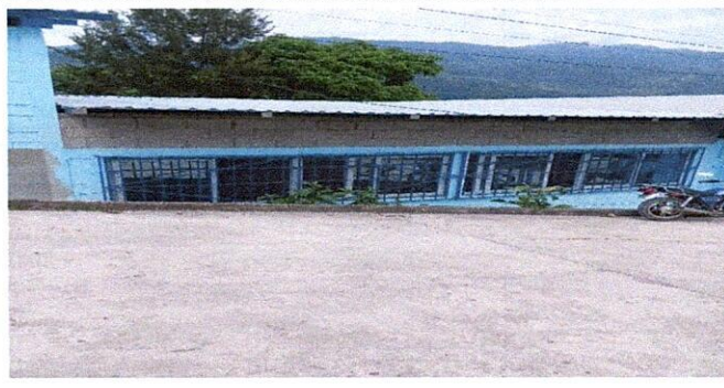
Foto 2: Parte de atrás del aula ya con techo.
