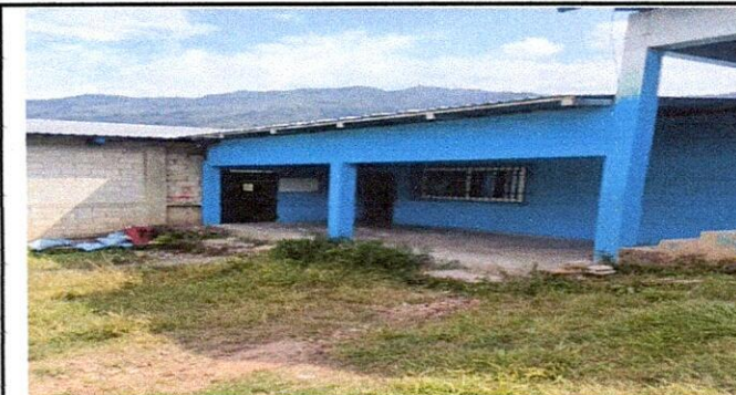
Foto 6: Parte exterior del aula ya culminada con ventanas y pintura
