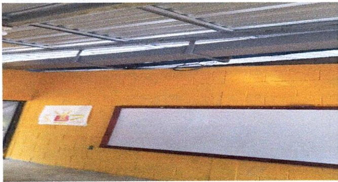
Foto1: Interior de aula ya con techo de lámina troquelada.
