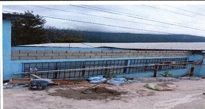
Foto 2: Techo del Instituto en proceso de avances.
