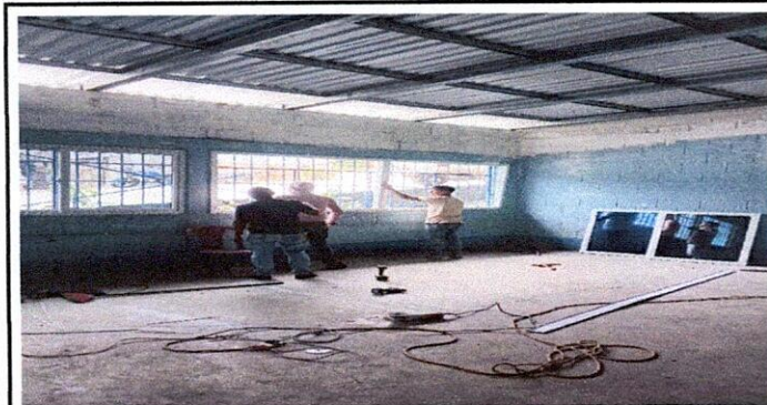
Foto 3: Instalación de Ventanas nuevas en aulas.
