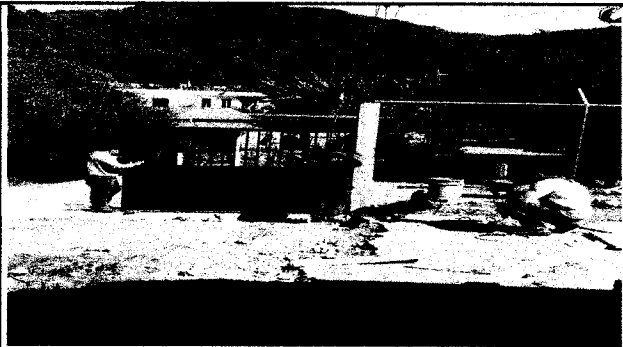
Foto1: Sustitución de portón de metal
