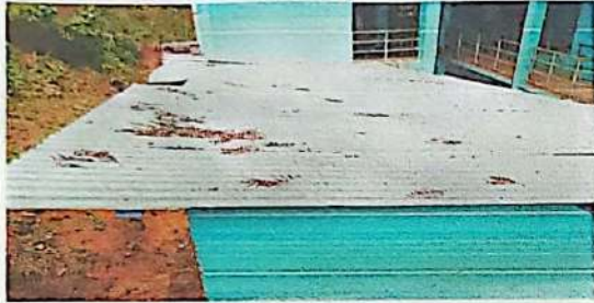
Foto 1: Cambio de techo de cocina
