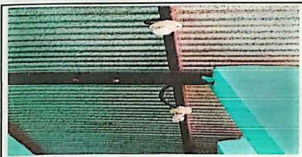
Foto 11: Sustrucción de lamparas tipo led
