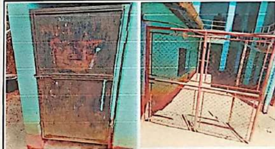
Foto 4: Sustitucion de puertas de servicios sanitarios y portón de metal
