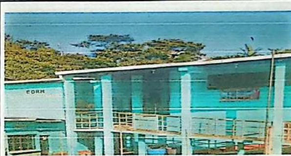
Foto 8: Pintura en muros exteriores e interiores
