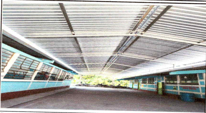
Foto1: Cambio de lamina por lamina troquelada aluzinc calibre 26.
