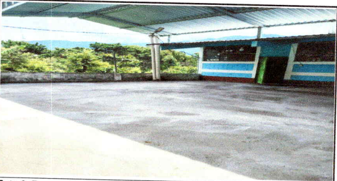
Foto 6: Reparación de plancha de concreto de patio
