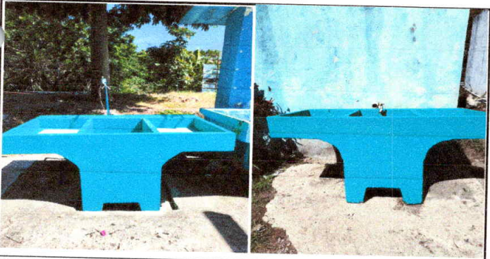
Foto 5: Cambio de pila de cemento de dos lavaderos
