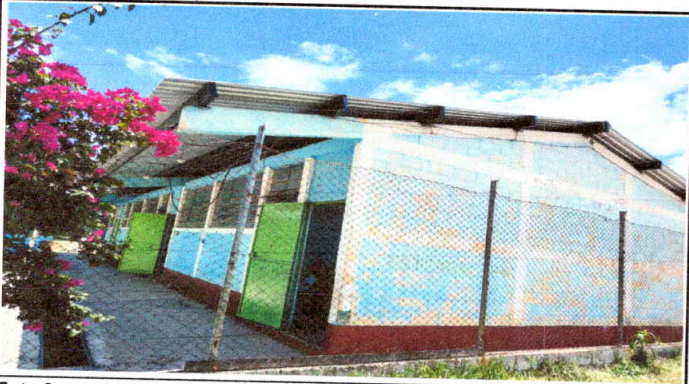
Foto 3: cambio de laminas por lamina troquelada
