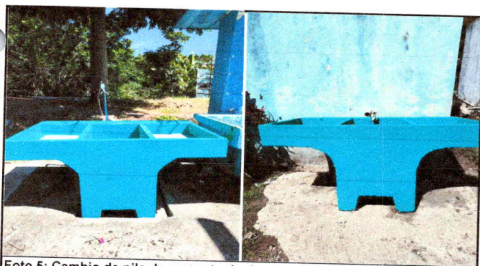
Foto 5: Cambio de pila de cemento de dos lavaderos
