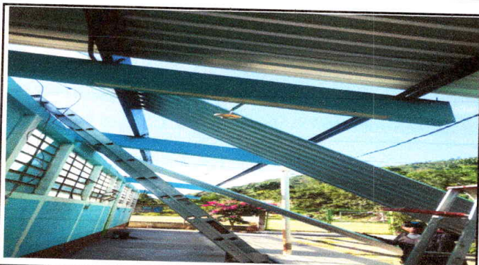
Foto 3: cambio de laminas por lamina troquelada
