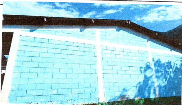
Foto 3: cambio de laminas por lamina troquelada
