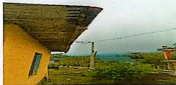
Foto 4: REGLÓN 7- CANALES Y BAJADAS DE AGUA PLUVIAL: se colocará en parte de la cocina
