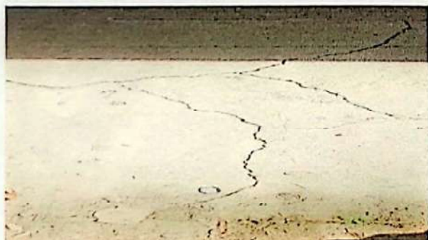
Foto 3: REGLÓN 6 PISO: En el piso de la cocina de torta de cemento se colocará piso de granito
