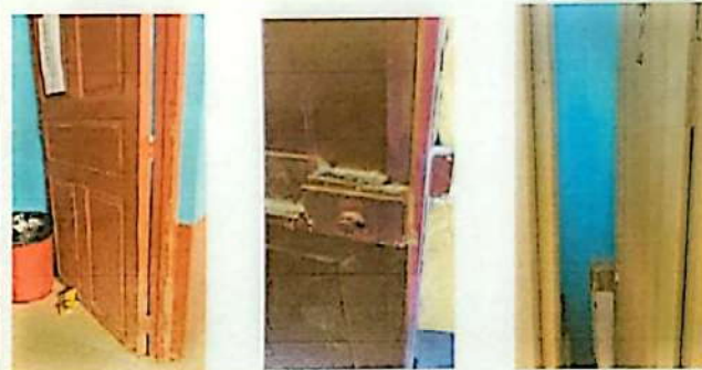
Foto 2: REGLÓN 4 PUERTAS DE METAL. Se cambiarán puertas de madera de salones de clase de 2.30 x 1 m, de baños por metal de 1.75 m x 0.60 m y sustitución de chapas marca yale.
