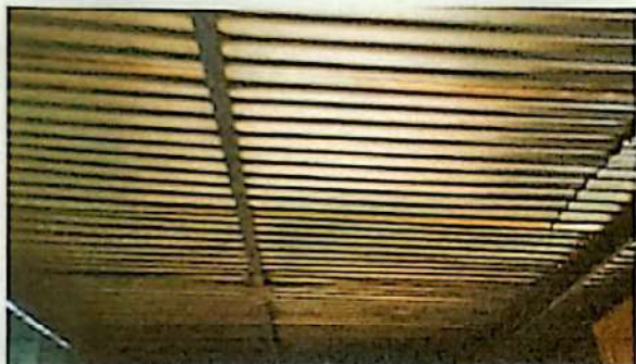
Foto 1: REGLÓN 1 Y 2. Se cambiará techo y estructura en el área de la cocina
