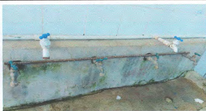
Foto 3: Sustitución de llave de chorro.
