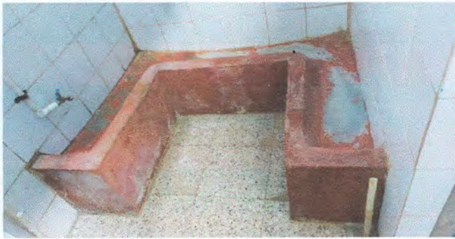
Foto1: Sustitución de azulejo para baños.
