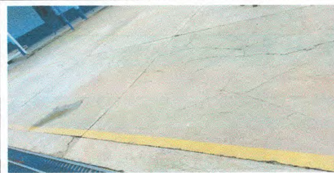
Foto 5: Reparación de planchas de concreto de patio.
