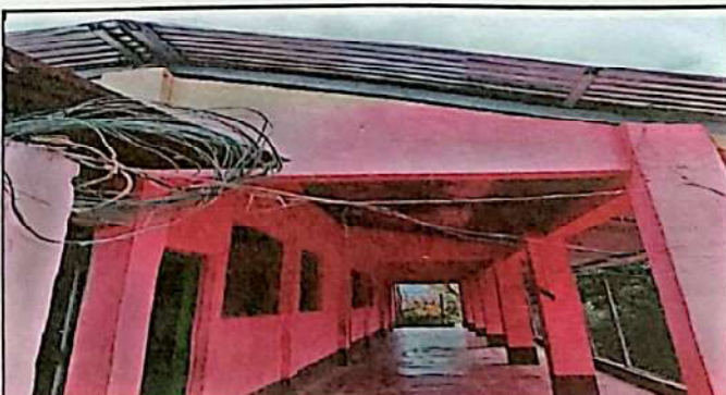
Foto 6: reparación sistema eléctrico
