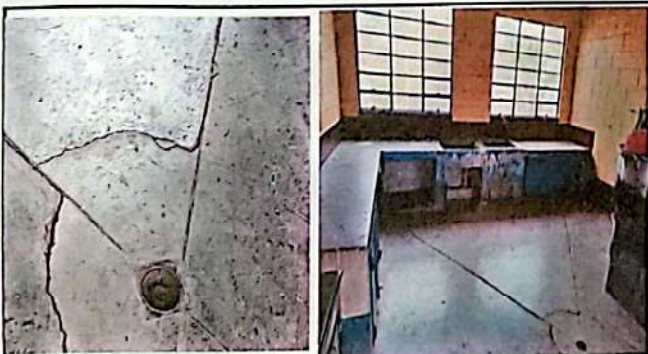
Foto 5: Reparación de cocina
