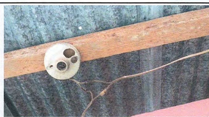
Foto 4: Reparación de sistema eléctrico
