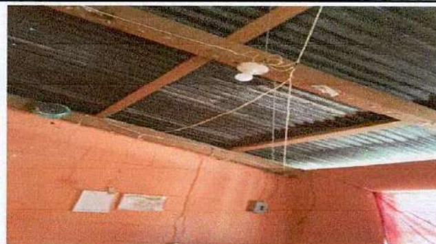
Foto 10: Reparación de sistema eléctrico
