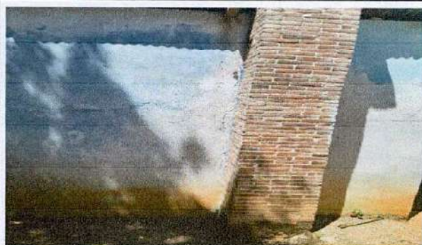
Foto 9: Sustitución de chimenea
