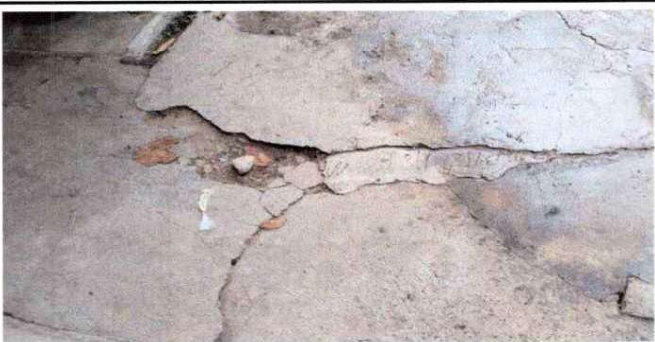
Foto 5: sustitución de piso de torta de concreto ya que esta quebrado y en mal estado.
