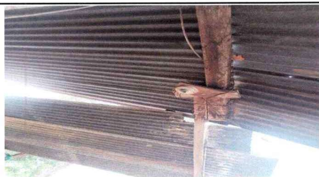
Foto 3: Sustitución de estructura de madera por metal ya que esta en mal estado
