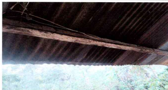
Foto 8: sustitucion de cabliado, toma corrientes e interruptores...
