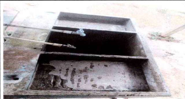
Foto 6: Sustitucion del tuberia y de las pilas que estan en malas condiciones.
