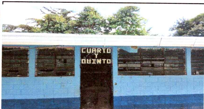
Foto 3: Sustitución de canales frente de las aulas finalizadas
