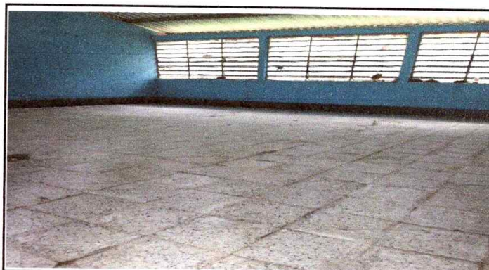
Foto 4:Sustitución de piso aula 1 de torta de concreto por piso de granito finalizadas
