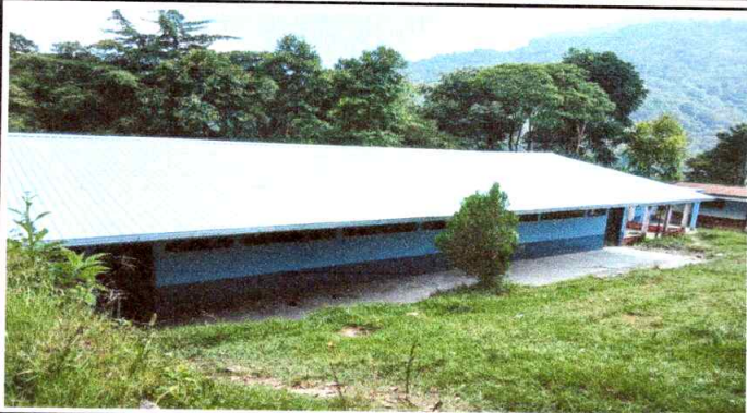
Foto1: Sustitucion de lamina por lamina Troqueladafinalizado.
