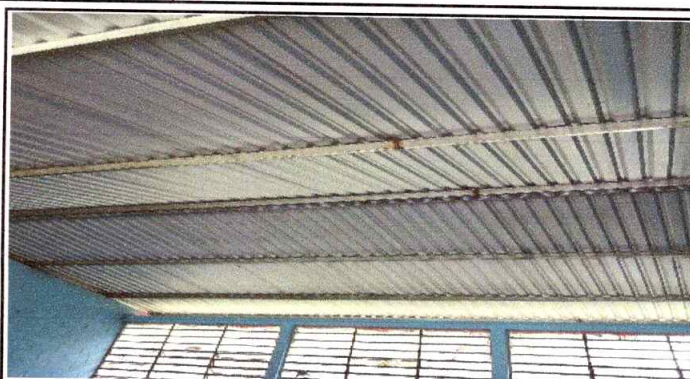
Foto 2 : Sustitucion de costaneras en aulas finalizadas
