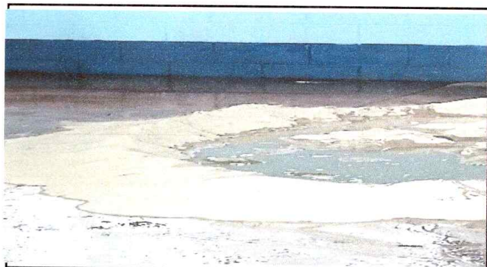
Foto 4: Sustrucion de piso aula 1 de torta de concreto por piso de granito, ya un 50% de asentando el piso
