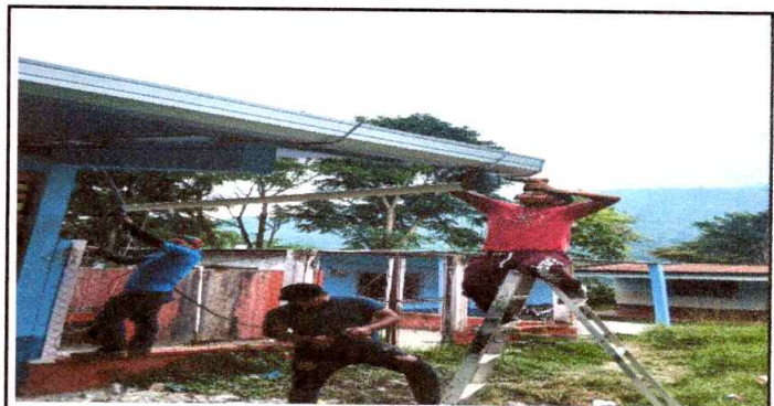
Foto 6: Sustrucion de Bajada de agua pluvial agregando un 50%
