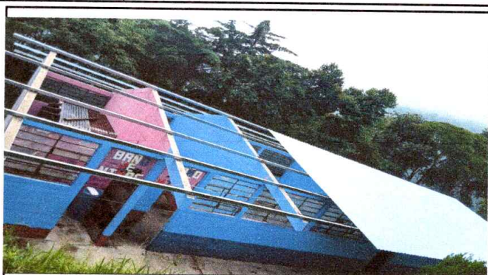
Foto 2 : Sustrucion de costaneras en aulas ya fue instalada
