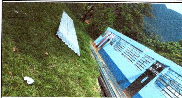
Foto1: Sustrucion de lamina por lamina Troquelada ya fue retida del techo
