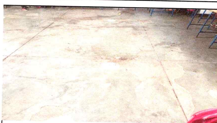
Foto 4:Sustitución de piso aula 1 de torta de concreto por piso de granito
