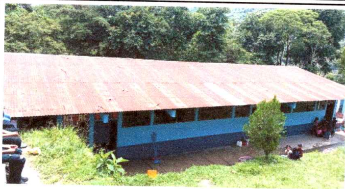
Foto1: Sustitucion de lamina por lamina Troquelada
