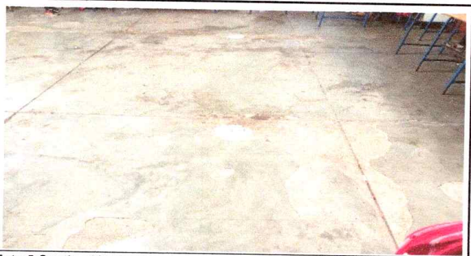
Foto 5:Sustitución de piso aula 2 de torta de concreto por piso de granito
