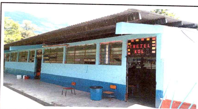
Foto 6: Sustitución de Bajada de agua pluvial
