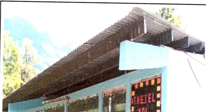
Foto 3: Sustitución de canales frente de las aulas
