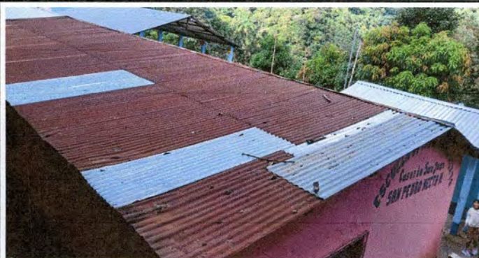
Foto 1: Sustiución de lámina, por lámina troquelada aluzinc calibre 26
