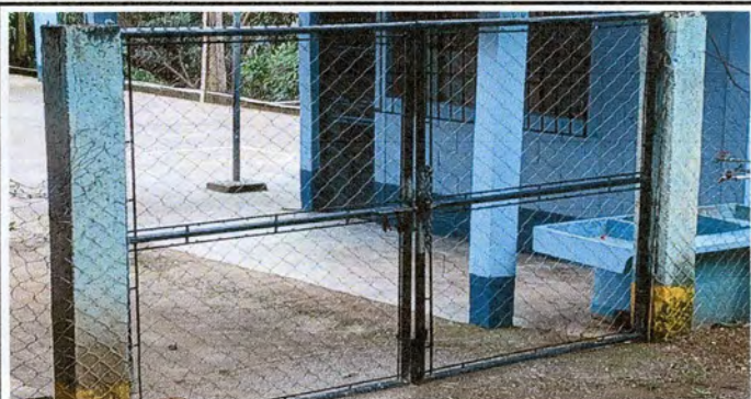
Foto 3: Sustitución de portón de metal (2.10 metros de alto*3 metros de ancho)
