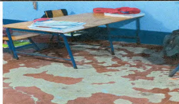
Foto 4: Sustitución de piso de granito por piso de granito
