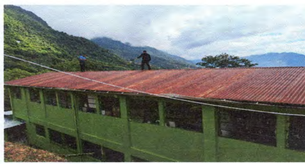
Foto 4: SUSTITUCIÓN DE CUBIERTA DE LÁMINA
