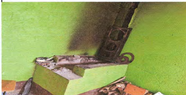
Foto 2: SUSTITUCIÓN DE ESTUFA RURAL COMPLETA (INCLUYE CHIMENEA Y PLANCHA DE METAL)
