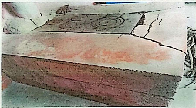
Foto 3: Sustrución de plancha de metal de 3 hornillas y Reparación de azulejo en muebles de cocina
