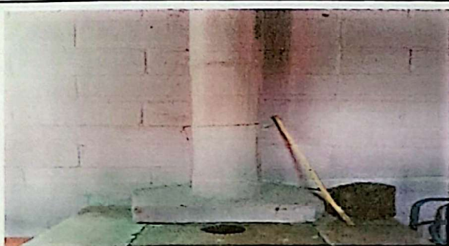
Foto 5: Sustrución de chimenea de concreto
