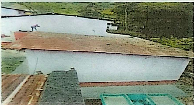
Foto 1: Sustrución de lamina, costaneras de techo por lamina troquelada y pestaña de cosina
