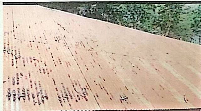
Foto 2: Sustrución de techo y costaneras de madera por costaneras de metal
