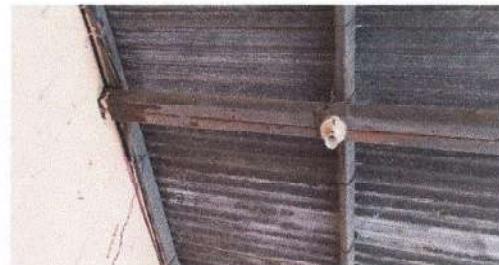
Foto 2: Sustitución de costaneras de metal
