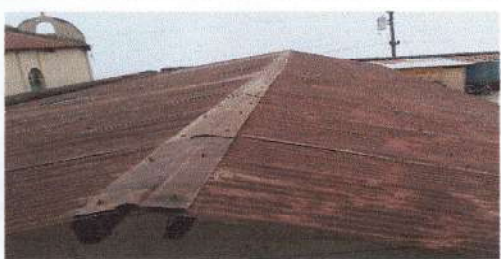
Foto 5: Sustitución de capos y canaletas
