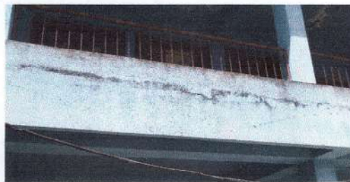
Foto 3: Mejoramiento o sustitución de pintura
