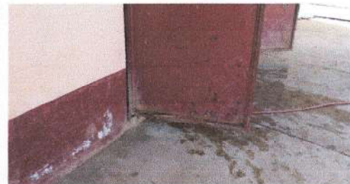
Foto 4: Sustitución de puertas
