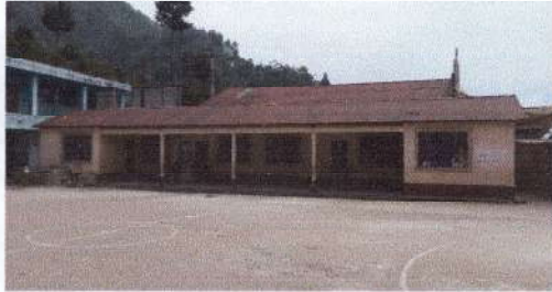
Foto1: Sustitución de lámina por troquelada en 4 aulas
