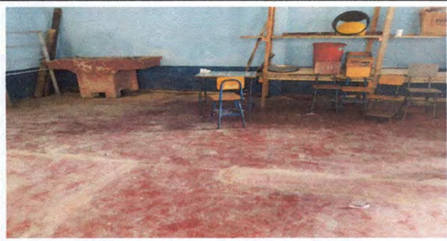
Foto 3: sustitución de piso de cemento líquido por piso de granito en cocina.
