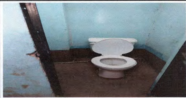
Foto 5: sustitución de inodoros
