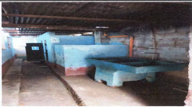
Foto 2: sustitución de lamina, por lamina troquelada alucinc en calibre 26 en baños.
