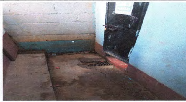
Foto 4: pintura en muros exteriores e interiores
