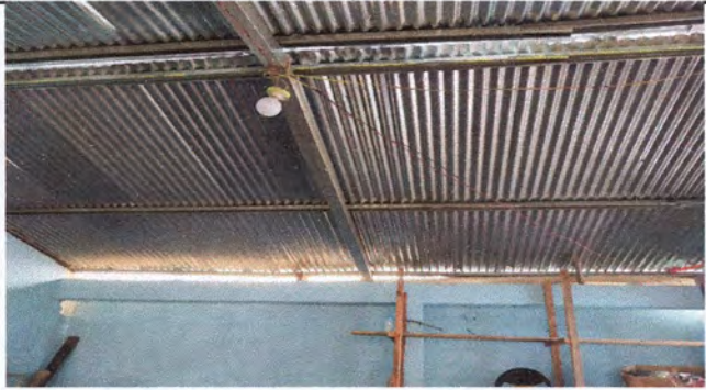
Foto1: sustitución de lamina, por lamina troquelada alucinc en calibre 26 en cocina.
