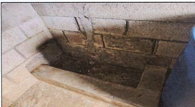
Foto 3: Sustrucción de mingitorios
