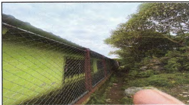
Foto 4: Instalación de canales y bajadas de agua pluvial
