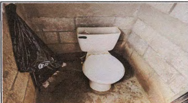
Foto 1: Sustrucción de inodoros
