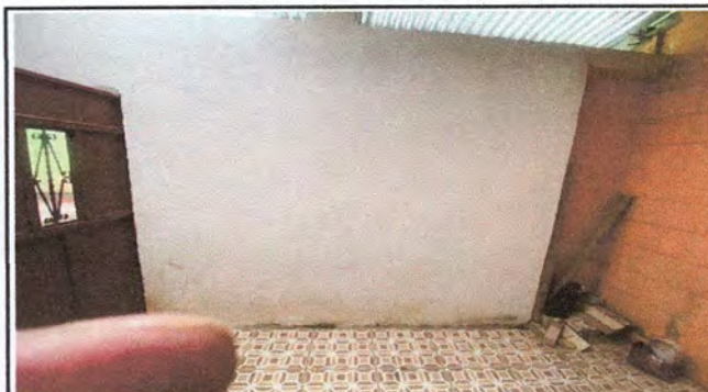
Foto 10: Restauración de lavadero
