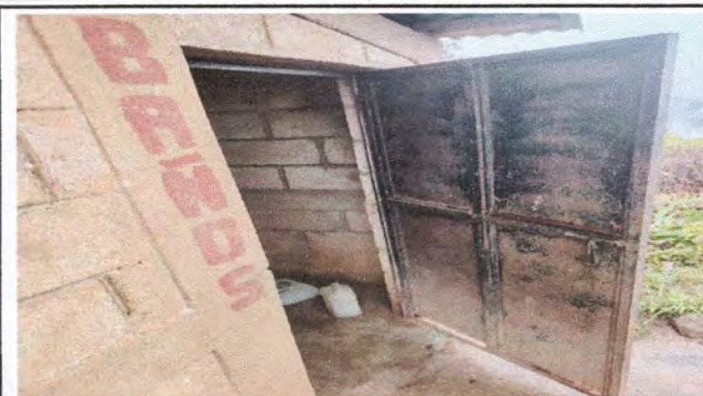
Foto 2: Sustrucción de puertas de sanitarios
