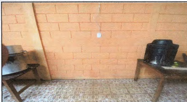
Foto 7: Reparación de lavatrastos
