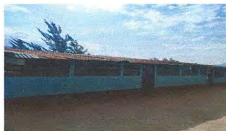
Foto 4: Pintura en exterior e interior
