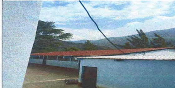
Foto2: Estructura de techo
