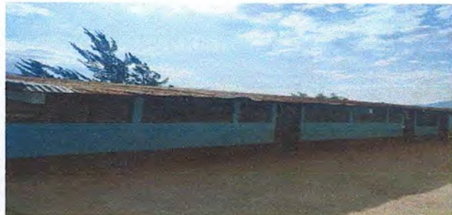
Foto1: Cubierta de lámina
