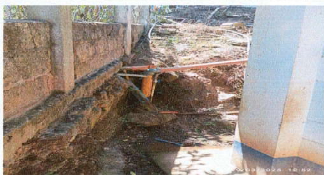
Foto 3: Sustitución de tubos de Drenaje
