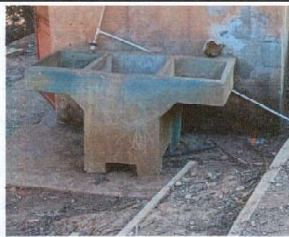
Foto 6: Sustitución de pilas
