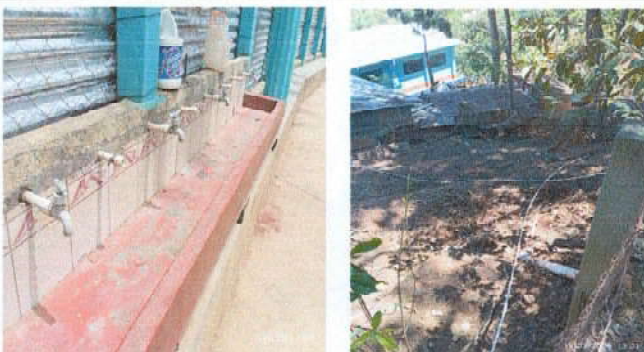
Foto 4: Sustitución de lavamanos y tubo de Agua Potable
