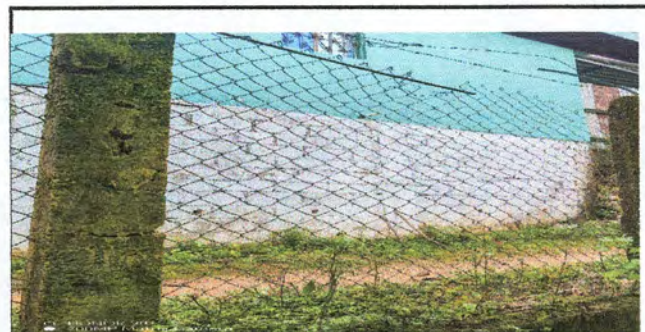
Foto 6: Reparación de tubo Hg y malla galvanizada
