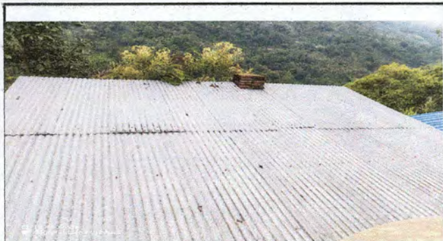
Foto 1: Sustitución de cubierta de lámina
