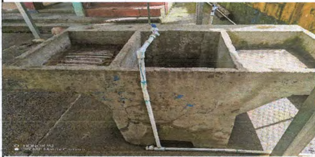
Foto 7: Sustitución de pila de 2 lavaderos
