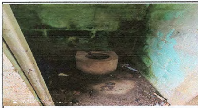
Foto 4: Sustitución de inodoro
