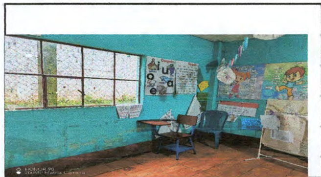
Foto 10: pintura de paredes interiores de aulas
