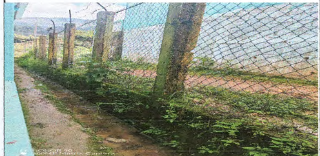
Foto 8: Repello y cernido de muro
