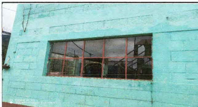
Foto 11: Mejoramiento con balcones de ventanas
