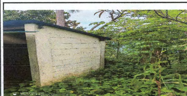
Foto 5: lugar donde se reparará la red de drenaje
