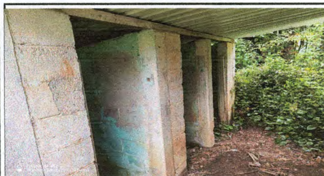
Foto 3: sustitución de puertas de madera por metal
