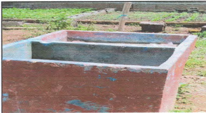
Foto 2: Sustitución de pila de concreto de dos labaderos
