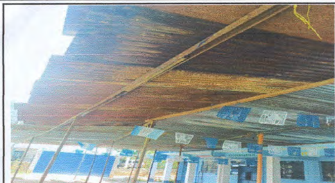
Foto 1: Sustitución de estructura de metal por metal
