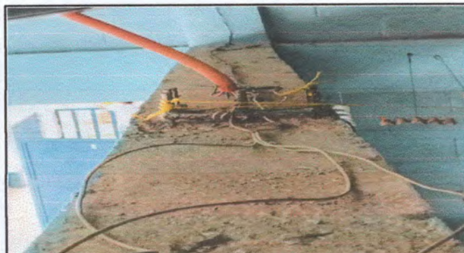
Foto 3: Sustitución y reparación de sistema eléctrico
