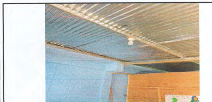
Foto 5: Sustitución de focos ahorradores
