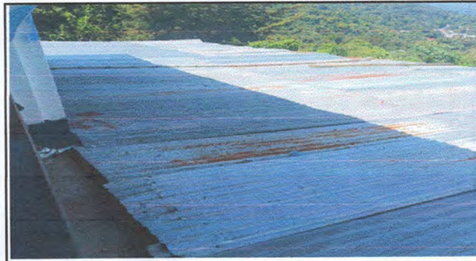
Foto 4: Sustitución de lámina de troquelada alucinc calibre 26
