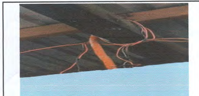
Foto 6: Sustitución de ducto eléctrico
