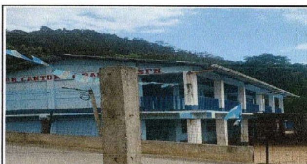
Foto 6: Pintado de paredes exteriores e interiores del centro educativo.
