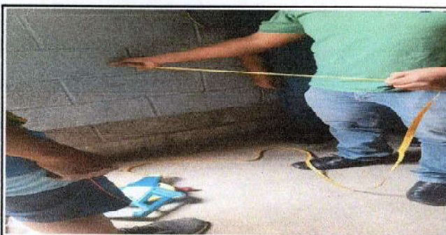
Foto 5: Sustrucción de mueble de cocina de concreto.B9
