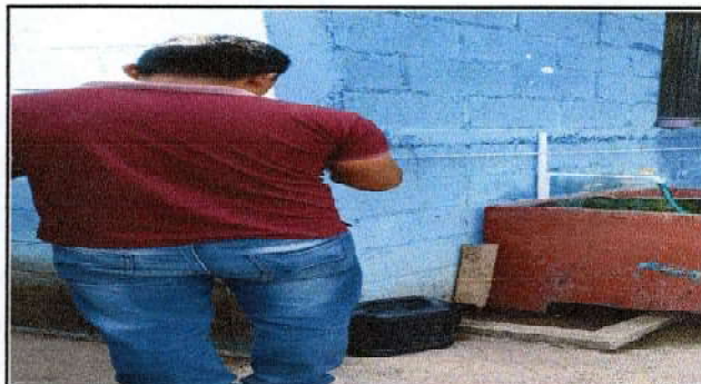
Foto 4: Sustrucción de pila de concreto de dos lavaderos
