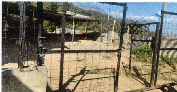
Foto 3: Sustrucción de porton de metal.
