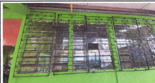
Foto 6: Sustrucción de balcones de metal (1.85m de alto * 2.10m de ancho)
