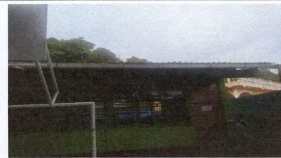
Foto 4: Sustrucción de canal de metal.
