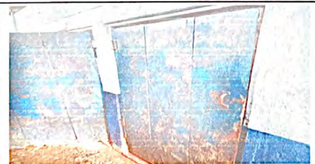
Foto 5: Sustitución de puerta (1.85m de alto * 0.90m de ancho).
