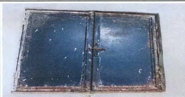
Foto 6: Sustrucción de estructura de metal de ventana (1 mtero de alto* 1 metro de ancho doble hoja)
