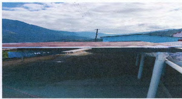
Foto 1: Sustrucción de lámina troquela aluzinc calibre 26
