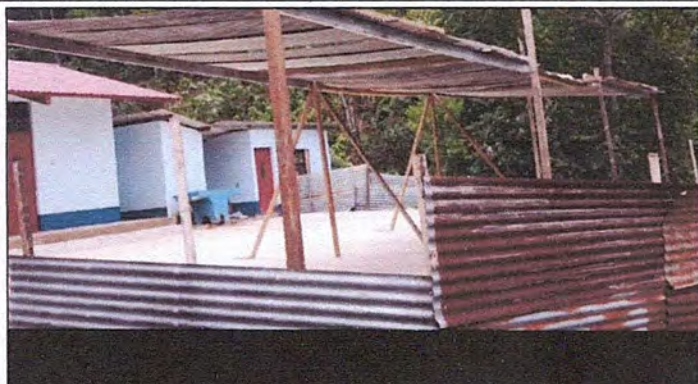
Foto 1: ESTRUCTURA DE TECHO
