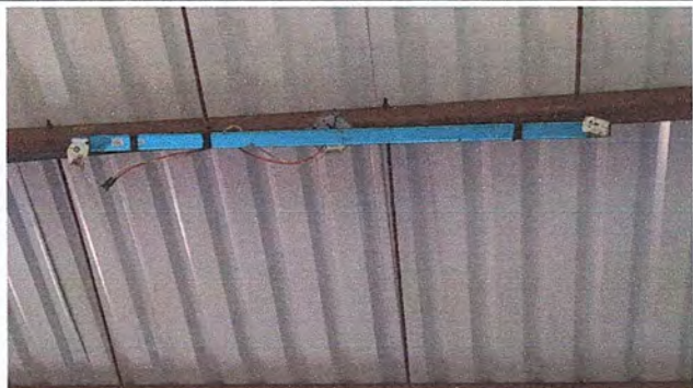
Foto 7: REPARACION DE SISTEMA ELECTRICO
