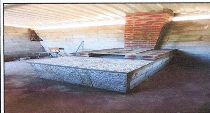
Foto 5: PINTURA EN MUROS Y EXTERIORES
