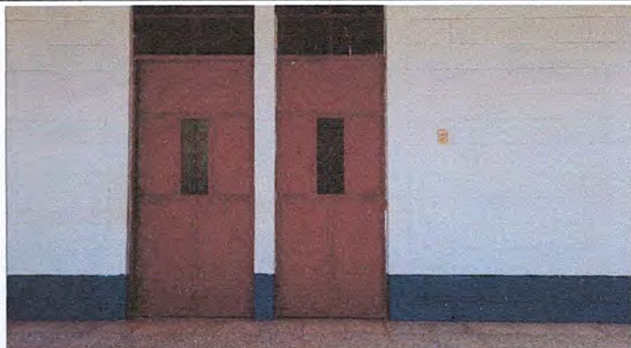
Foto 2: SUSTITUCION DE PUERTAS DE METAL
