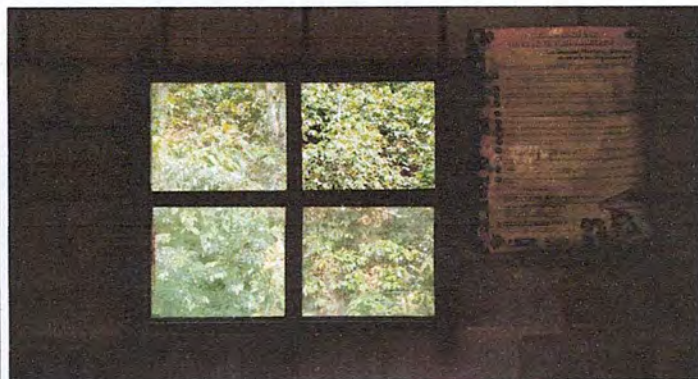
Foto 3: SUSTITUCION DE VENTANAS
