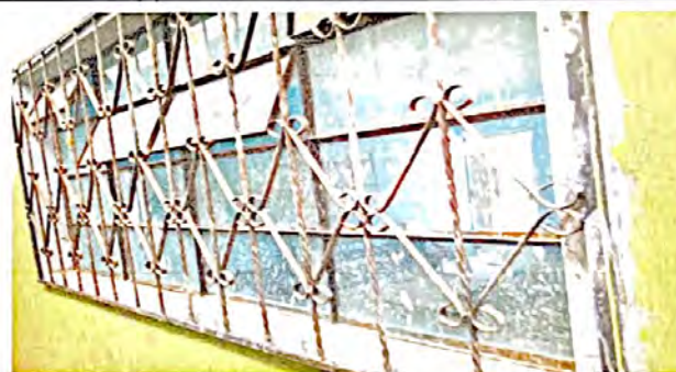
Foto 4: Sustrucción de estructura de metal de ventana.
