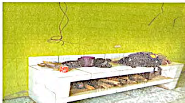
Foto 6: Reparación de azulejo en muebles de cocina.
