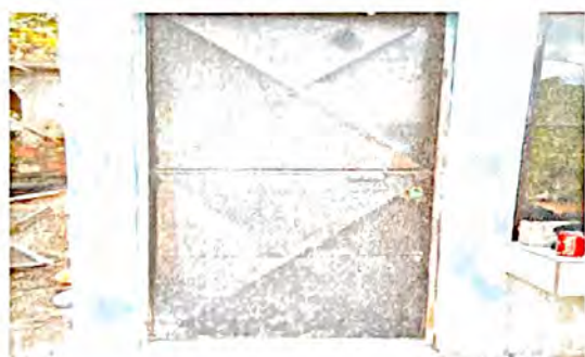
Foto 3: Sustrucción de puertas.
