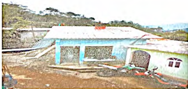
Foto 5: Pintura en muros exteriores e inferiores
