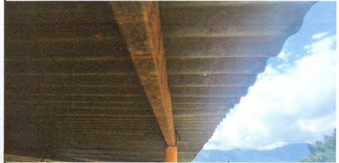
Foto 2: Costaneras deterioradas
