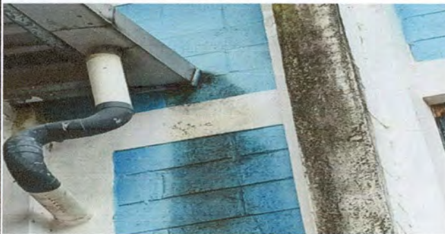
Foto 3: Cambio de canales
