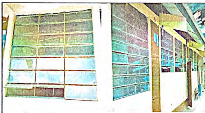
Foto 3: Sustrucción de balcones de metal
